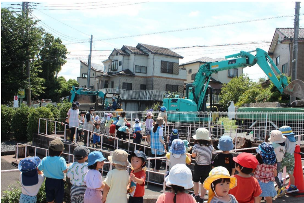
園前の道路が工事中、みんなで重機を見学にいきました。 間近でみる迫力にみんな大興奮。
